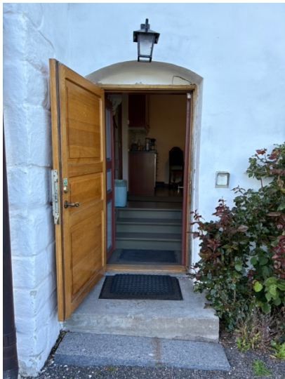
Inngangsdør til sakristi – utvendig.
